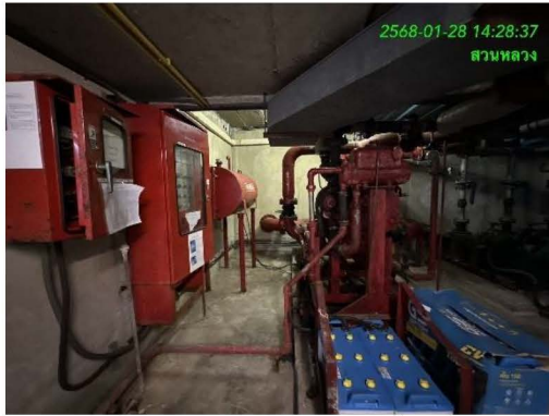
ภาพที่ 2-57 เครื่องสูบน้ำดับเพลิง
